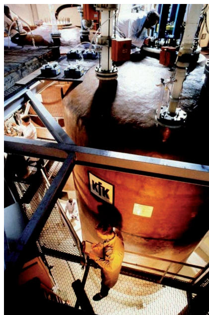
Arbeiten an den GALLEX-Tanks, von denen einer mit 101 t Galliumchlorid-Salzsäurelösung gefüllt war; der zweite diente als Sicherheitsreserve.
